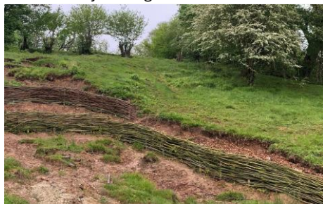
Willow 'spiling' to stabilise a landslip
